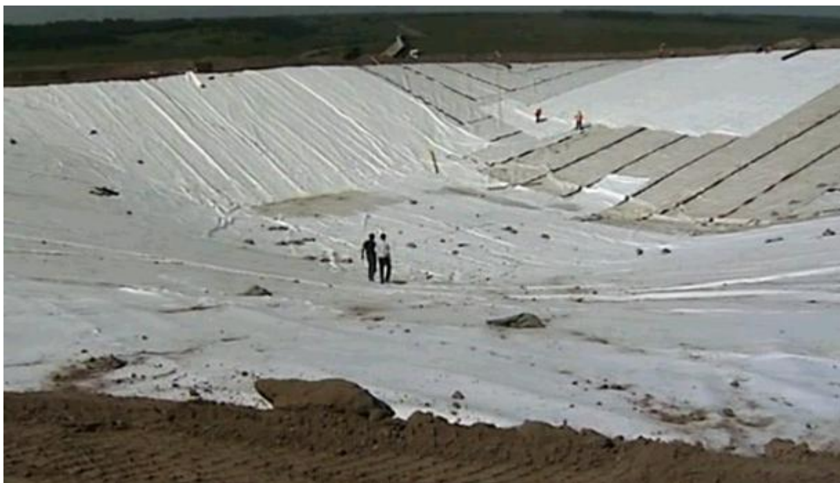
Рисунок 4 – Строительство площадки для хранения загрязненных отходов АМЗ
