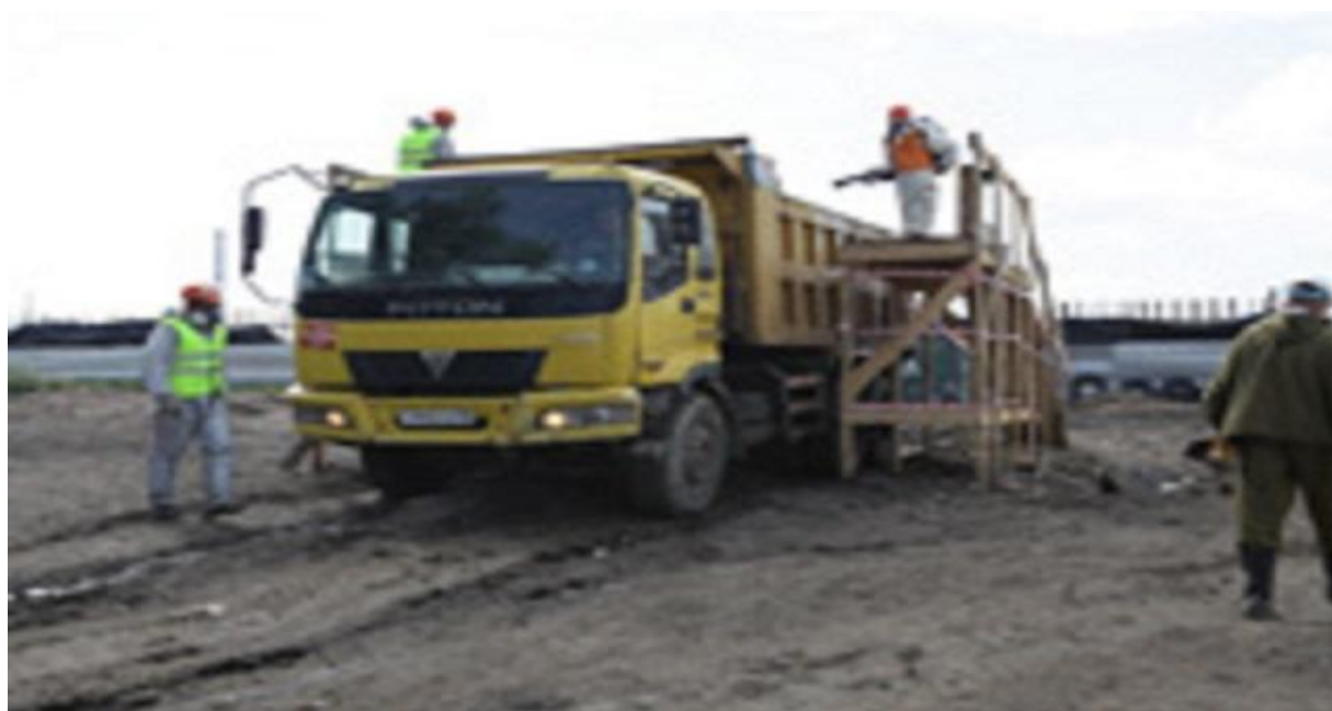
Рисунок 3 – Вывоз загрязненных отходов производства, цехов и почвы
